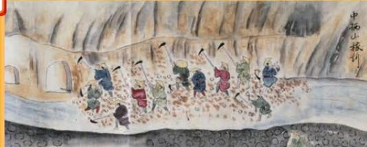
2 掘りくずした土に、堤にためていた水を勢よく流して、不要な土砂をとり除く(大流し)
